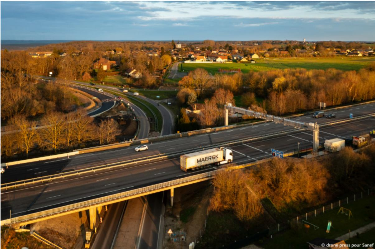
Projet d'envergure du groupe Sanef, le déploiement du flux libre sur les 210 km entre Paris et Caen va révolutionner notre manière de circuler. Comment ? Les barrières de péage sont remplacées par des portiques équipés de capteurs intelligents qui identifient les véhicules et calculent le montant du péage en fonction de sa catégorie et du trajet réalisé.
