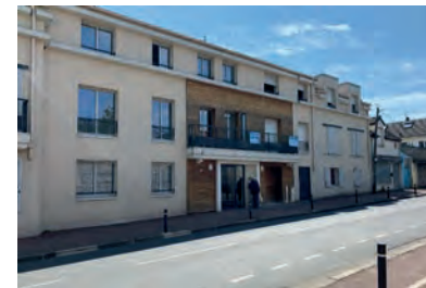
CONSTRUCTION CONTEMPORAINE RUE DE LA LIBERTÉ
