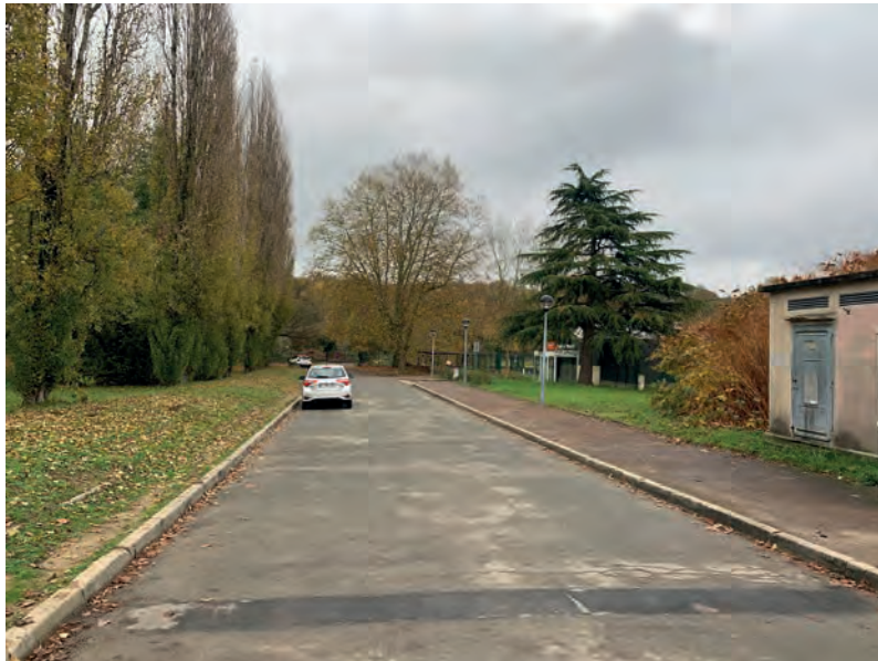
6 // IMPASSE DU PARC // UNE LARGEUR SUFFISANTE POUR L'ACCÈS AU CTM // LA VÉGÉTATION ALENTOUR MASQUE LE SITE DANS LE PAYSAGE
