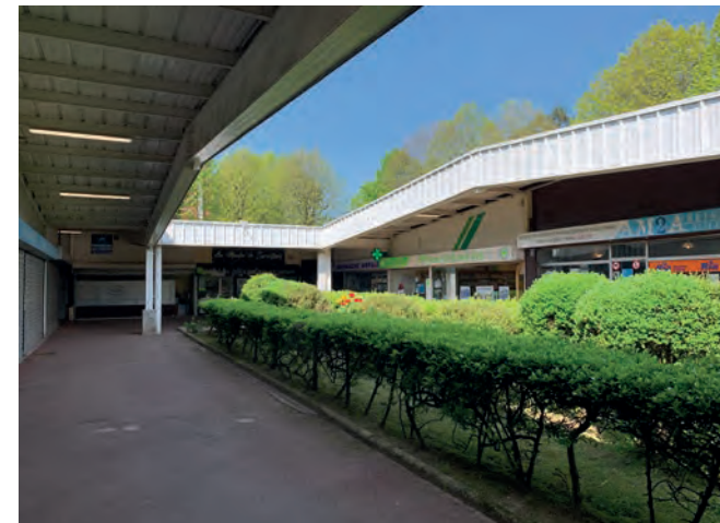
CENTRE COMMERCIAL DU COLOMBIER
