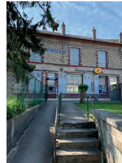
BÂTIMENT DE LA POSTE
