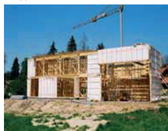
Chantier d'une maison à ossature bois
