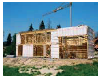
Chantier d'une maison à ossature bois
