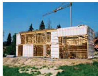
Chantier d'une maison à ossature bois
