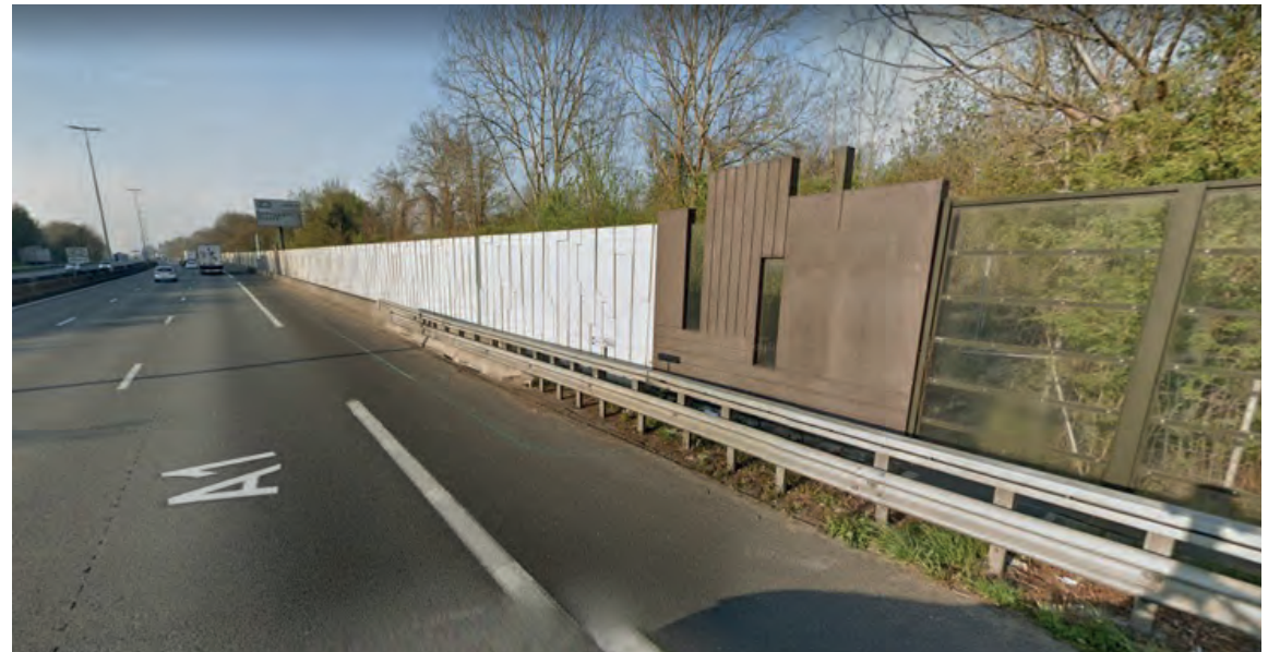
9 // VUE DEPUIS L'AUTOROUTE SENS NORD/SUD // LE MUR ANTI-BRUIT ET LA VÉGÉTATION EMPÊCHENT TOUTES VUES SUR LE SITE
