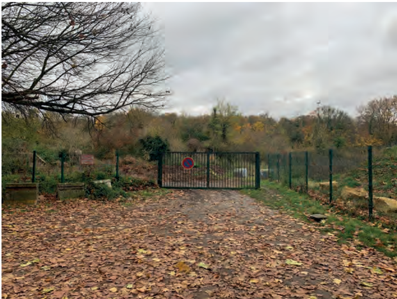
3 // ACCÈS ACTUEL AU SITE AU BOUT DE L'IMPASSE DU PARC // PRÉSENCE D'UN PORTAIL DE LARGEUR SUFFISANTE
