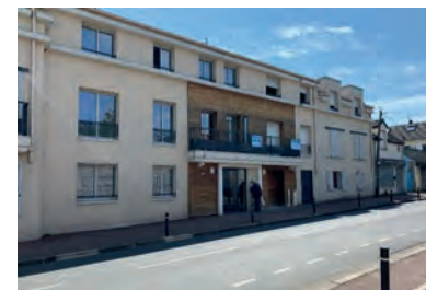
CONSTRUCTION CONTEMPORAINE RUE DE LA LIBERTÉ
