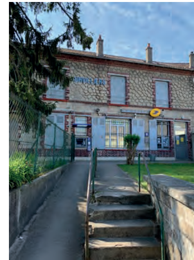
BÂTIMENT DE LA POSTE
