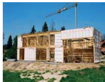
Chantier d'une maison à ossature bois
