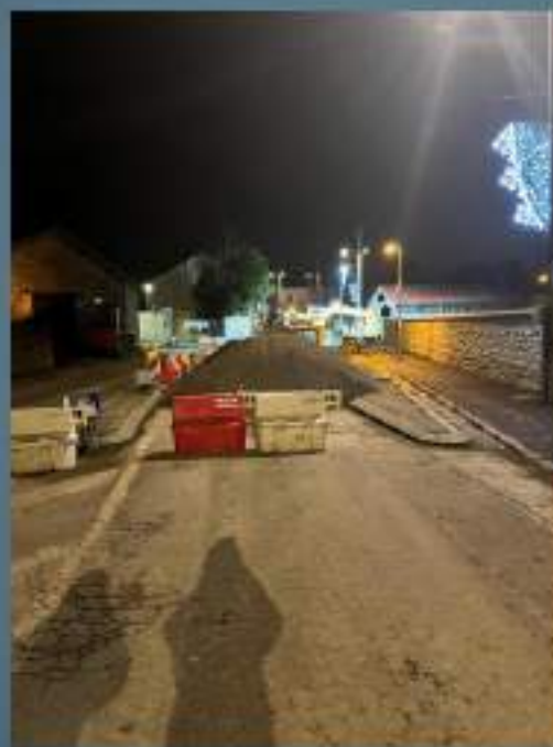
Travaux de pose du réseau EU sous la route départementale de nuit avec route barrée
