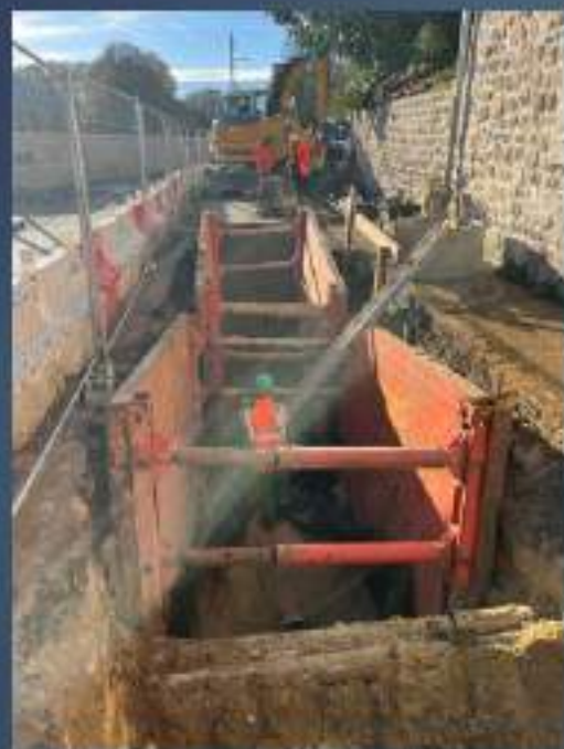
Travaux de pose de la nouvelle canalisation en fonte de diamètre 200mm
