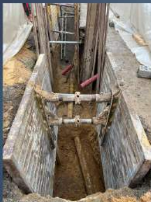
Travaux de dépose de la canalisation existante en amiante-ciment
