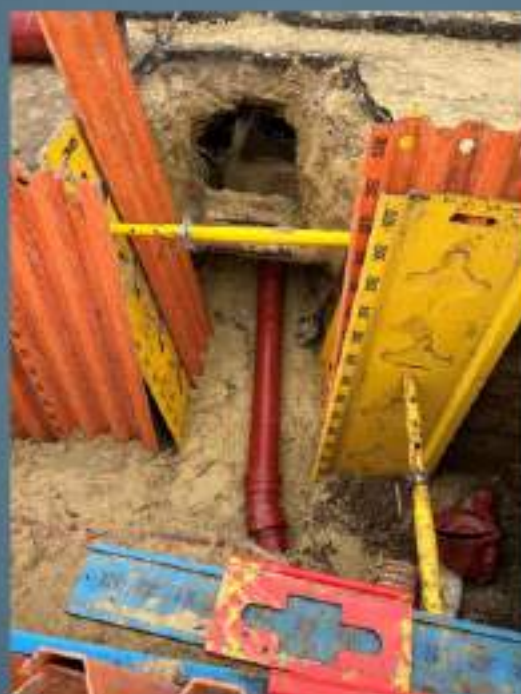
Travaux de pose d'un branchement particulier de diamètre 150mm raccordé en culotte
