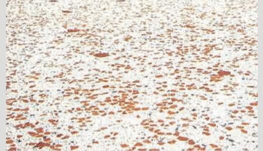
Béton incrusté-bouchardé issu du réemploi de tuiles du village
