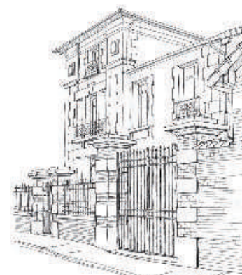
Grilles, portillon et portail en ferronnerie entre piles de brique et pierre en alternance, sont en harmonie avec l'architecture des villas
