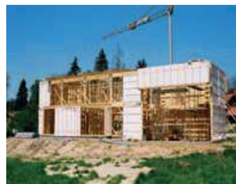
Chantier d'une maison à ossature bois
