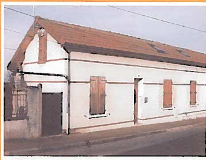
Pavillon double pour ouvriers de 1906, Dans la 1 re rue Charles Gabel. Il garde à peu près son aspect d'origine, hormis les volets qui ont été échangés. Il en existe trois exemplaires, plus un muni ultérieurement d'un étage.
