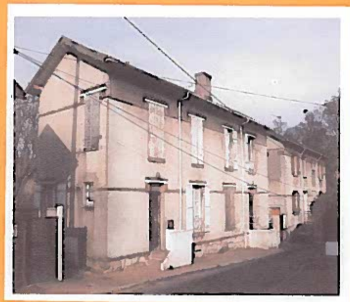
Maison double pour sous-chefs, d'avant 1914, dans la 1 re rue Charles Gabel. Il existe en deux exemplaires.
