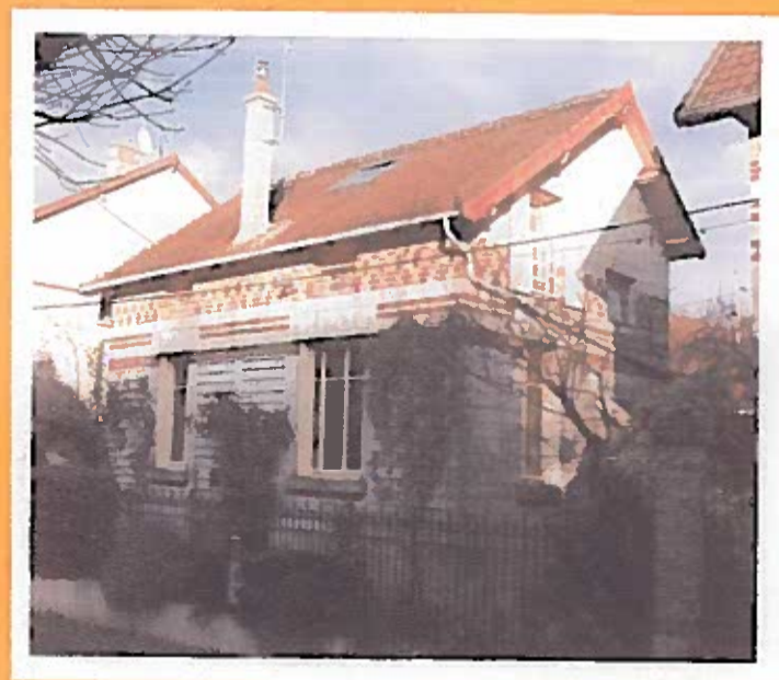
Maison pour chef de service, dans la 2 e rue Charles-Gabel. Un des 4 exemplaires réalisés, Dont 3 pour une famille. Equipée d'un salon en plus de la salle à manger.
